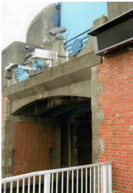
写真-4 レンガ張りの六郷水門
