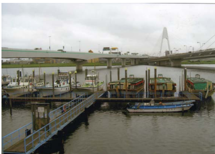
写真-5 大師橋（右）と高速大師橋（左）に挟まれた船溜り
