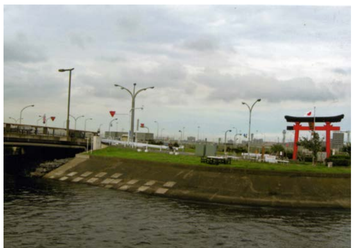
写真-11 稲荷橋と羽田平和の大鳥居
