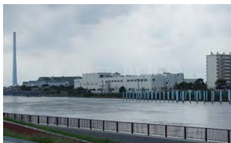
▲ 常夜灯公園から篠崎ポンプ所を望む
