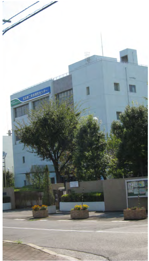
▲ 北多摩二号水再生センター
