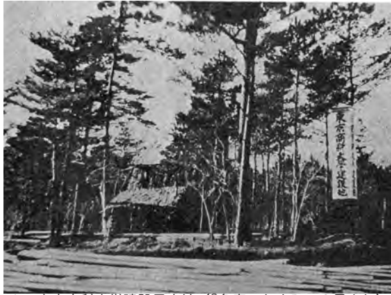
▲ 東京商科大学建設予定地（『多摩のあゆみ』6号より）
