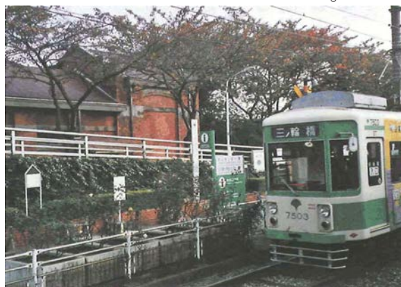
▲ 旧三河島污水処分場唧筒（ポンプ） 場施設と都電
