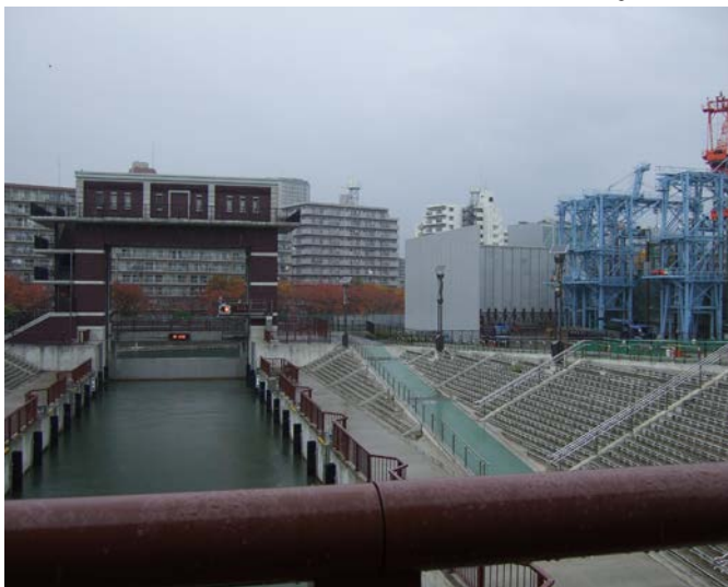
▲ 荒川ロックゲートと工事の進む小松川第二ポンプ所（右）
