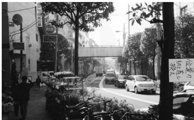
▶大正時代の空橋
